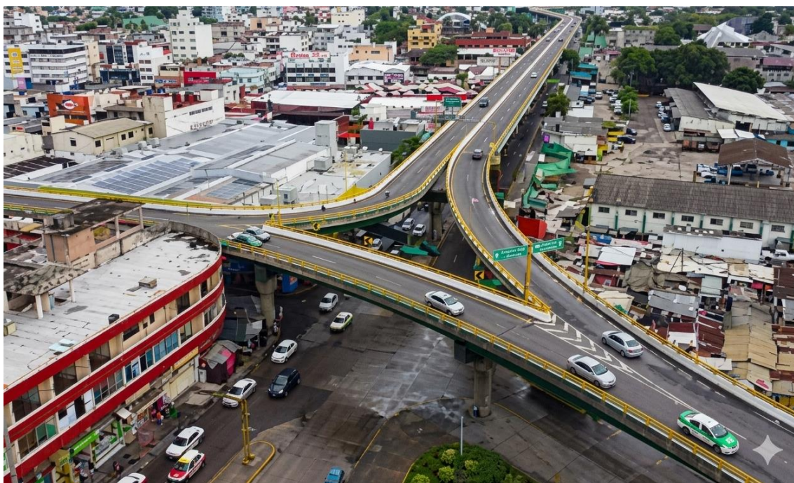
Figura 7: Distribuidor vial zona centro de poza rica
